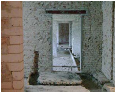
Laborumbau im vollen Gange
